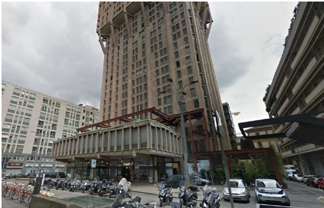
Fondiarria Sai S.p.a. – Risanamento facciate Torre Velasca - Milano Realizzazione struttura in carpenteria metallica a sostegno ponteggi
