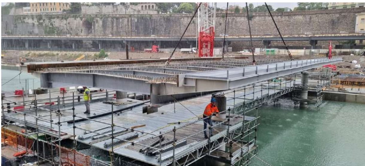
Comune di Genova – Recupero Waterfront di Levante – Ponte su canale principale: varo impalcato centrale
