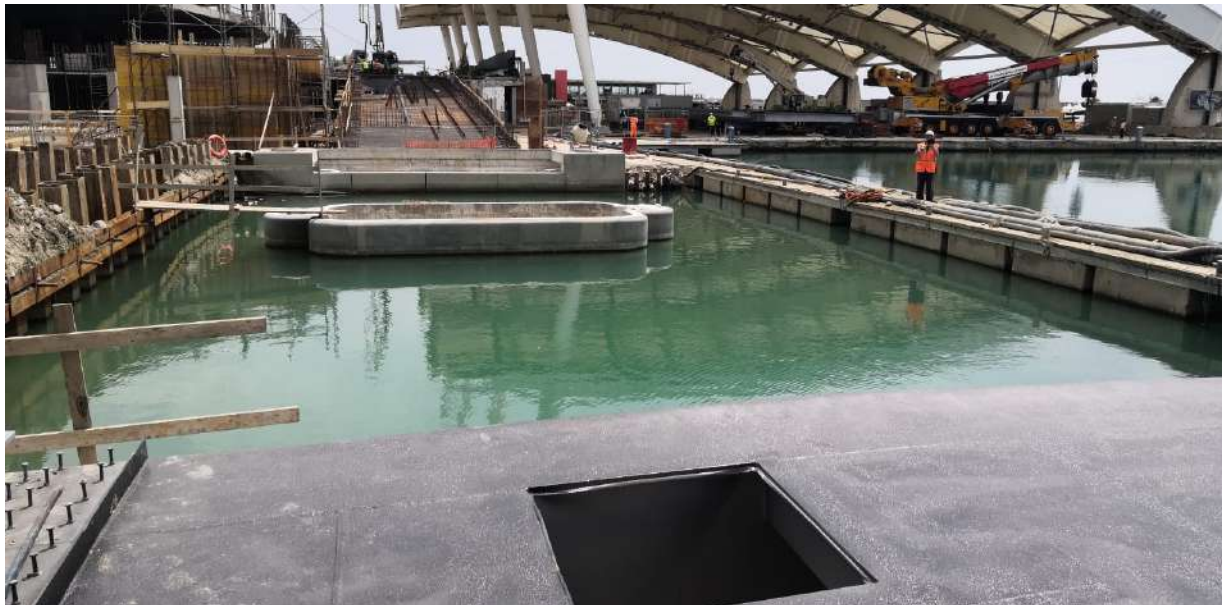
Comune di Genova – Recupero Waterfront di Levante – Ponte su canaletto: vista delle pile e della spalla est
