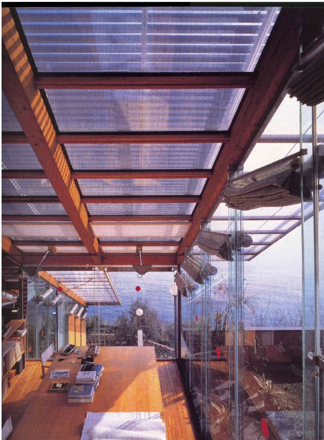
Laboratorio per ricerche naturali "Unesco - Renzo Piano Building Workshop " a Genova-Crevari: serra-laboratorio su più livelli in cls, acciaio e legno lamellare
