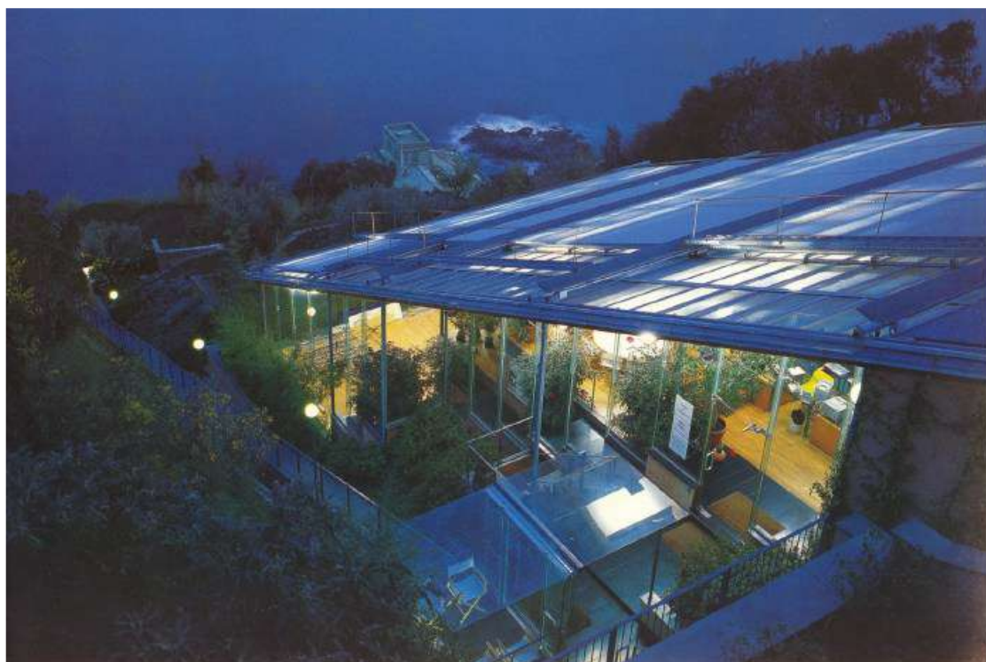
Laboratorio per ricerche naturali "Unesco - Renzo Piano Building Workshop " a Genova-Crevari: serra-laboratorio su più livelli in cls, acciaio e legno lamellare
